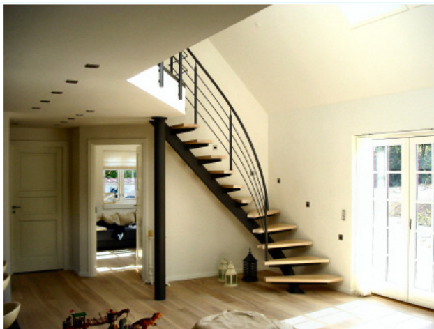
Fig.2 Opsadlet center ståltrappe: Bemærk at centervangen her, er drejet til lidt mere-end kvartsving, som giver et mindre-dominerende 1. trin, af hensyn til ganglinier og tilgængeligheden.
