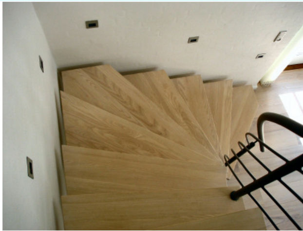
Fig.4 Opsadlet center ståltrappe: venstre-sving med faconskårede fyrplank trin. Gelænder-håndliste, balustre, medløbere og trappevange pulverlakeret i standard RAL farve, koksgrå.
