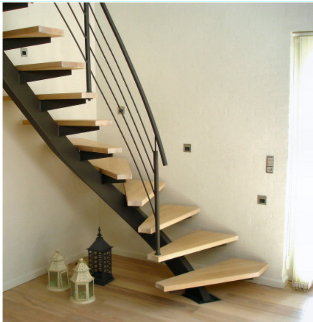
Fig.5 Opsadlet center ståltrappe: Gelænder-håndliste, balustre, medløbere og trappevange pulverlakeret i standard RAL farve, koksgrå.
